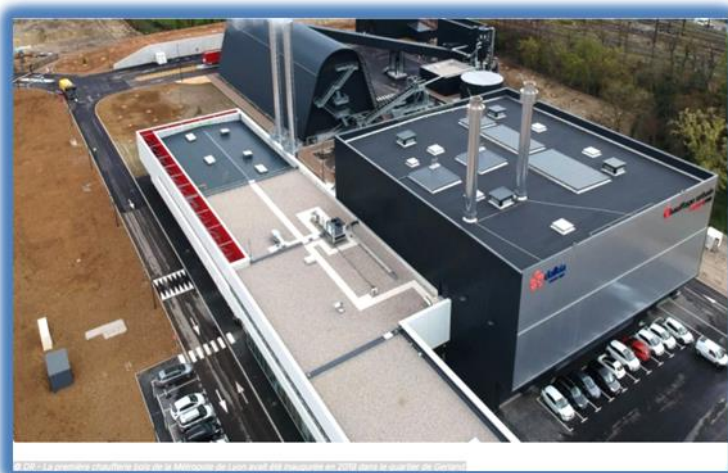
©la 1ère chaufferie de la métropole de Lyon avait été inaugurée en 2019 dans le quartier de gerland
