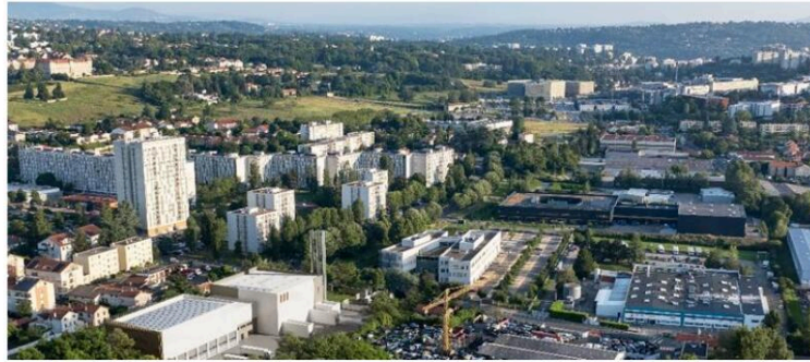
Nous ne publierons pas de photo de l'assemblée car certains s'y sont opposés. Ici la chaufferie bois (au centre de la photo) implantée dans le quartier de La Mouche. Photo Fournie Par Coriance
